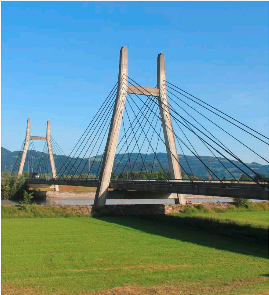
Ein Wahrzeichen von Diepoldsau, die 1983 bis 1985 erbaute Schrägseilbrücke über den Rhein.
